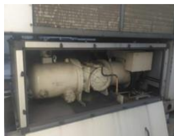
Gambar 1 Kompresor Chiller
