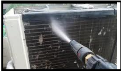
(c) Penyemprotan Condensor
