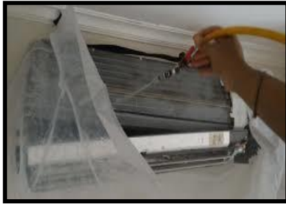
(b) Penyemprotan Evaporator
