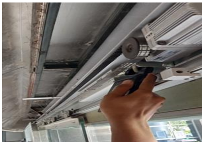
Gambar 16 Pengecekan putaran motor
