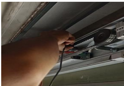
Gambar 17 Pengecekan kelistrikan power supply unit
