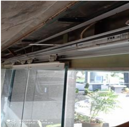
Gambar 3 Pintu Geser Otomatis Merk “Dorma” Seri ES-100
