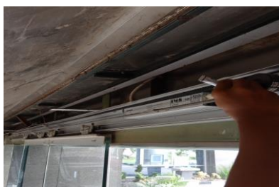
Gambar 10 Pelumasan pada bagian van belt
