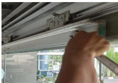
Gambar 9 Pengencangan baut
