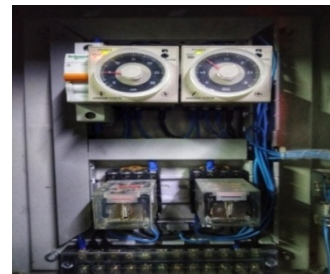
Gambar 3.1 Rangkaian Kontrol Blow down
