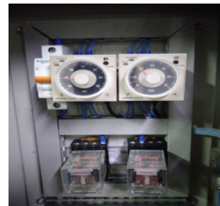
Gambar 4.13 Rangkaian Blow Down
