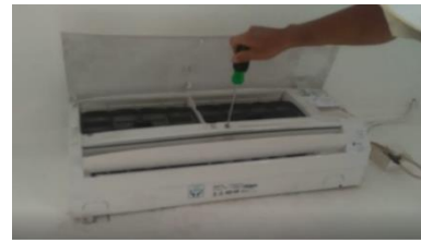
Gambar 9 Pelepasan Cover AC
