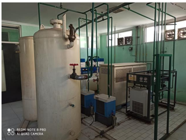
Gambar 2 Sistem Gas Udara Tekan Medis
