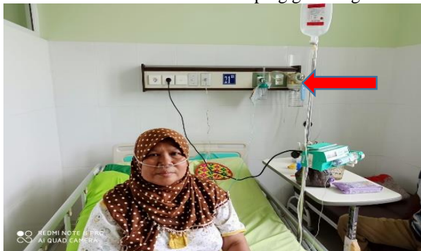
Gambar 3. Letak outlet vacuum medis disamping gas oksigen.
