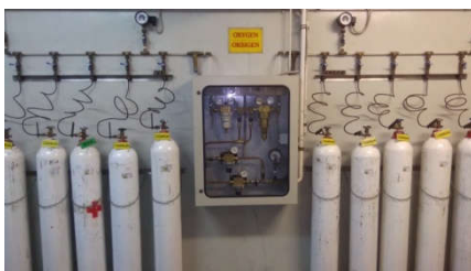
Gambar 4.4 Sentral Gas Tabung Oksigen
