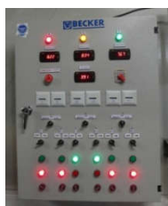
Gambar 5 Panel Kontrol Mesin Kompresor
