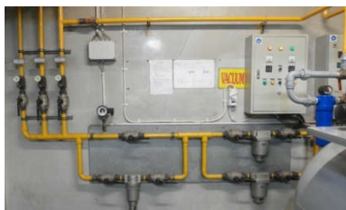
Gambar 10 Filter dan Valve induk
