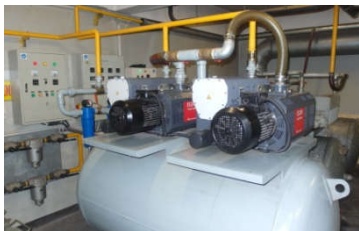
Gambar 9 mesin vakum
